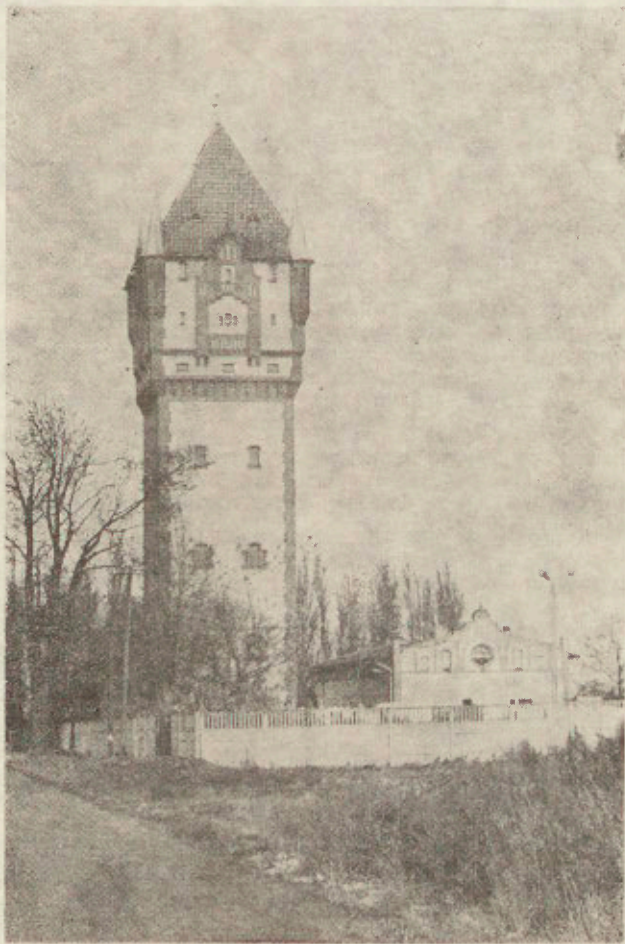
28. Wieża wodociągowa w Kościanie.
