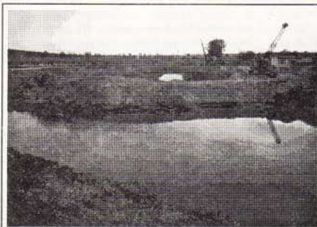
Budowa jazu na Obrze pod Krzywiniem
