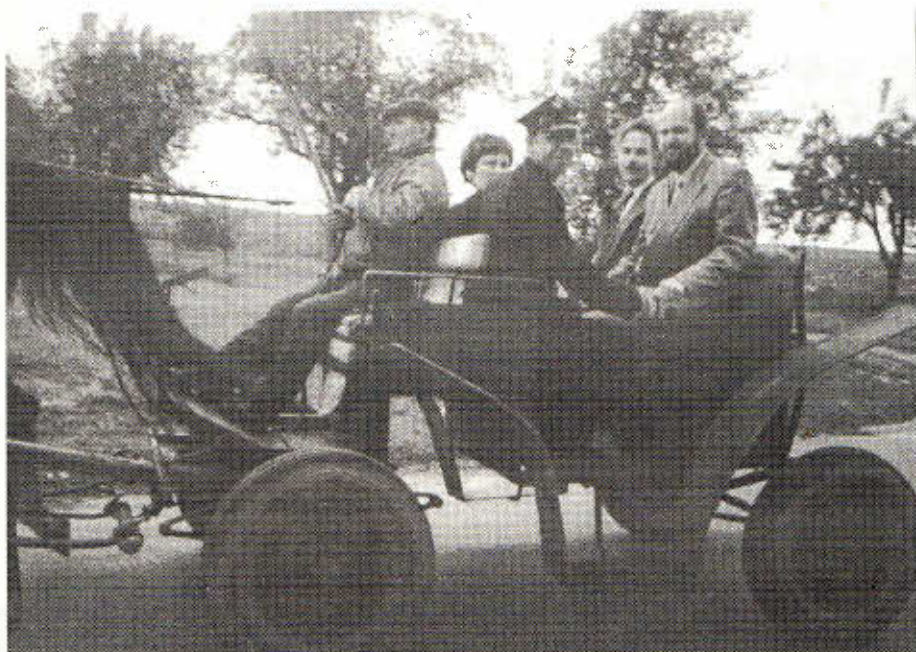
Przejażdżka nową nawierzchnią drogi w Bielewie
