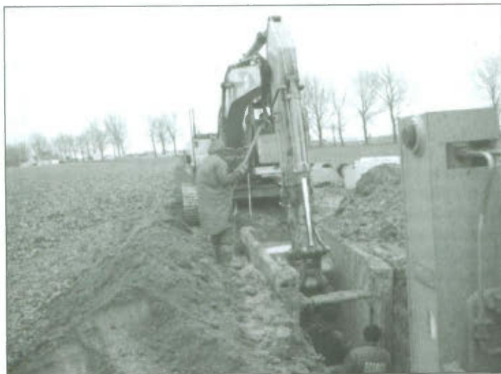
Prace przy budowie kanalizacji deszczowej w Lipnie
