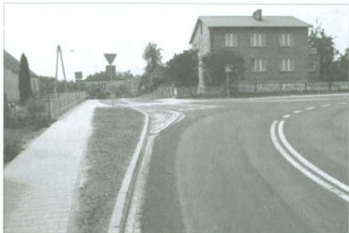
Skrzyżowanie w Żakowie po remoncie
