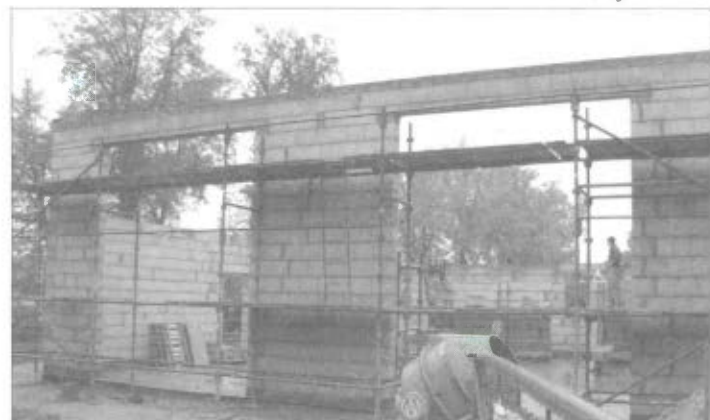
Bramy wjazdowe już stoją
