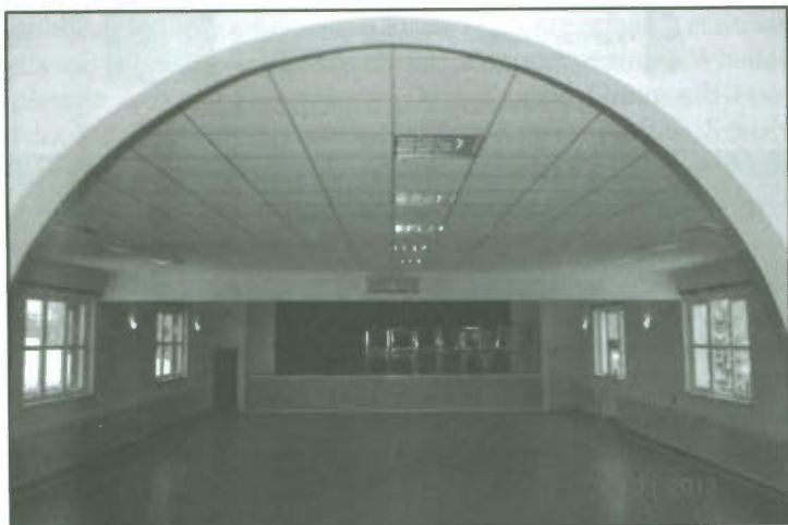
Dom Strażaka w Wilkowicach po modernizacji.
