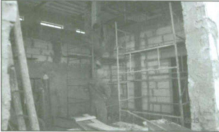
Prace w pomieszczeniu gospodarczym przy Gimnazjum w Lipnie.
