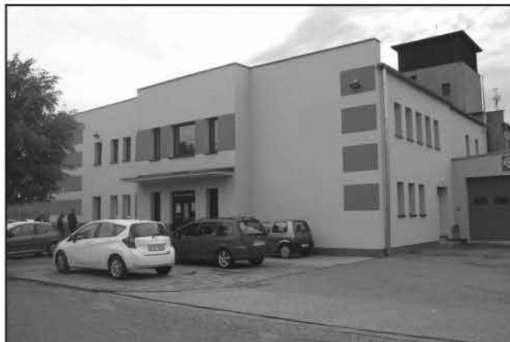
Elewacja frontowa budynku Gminnego Ośrodka Kultury w Lipnie.
