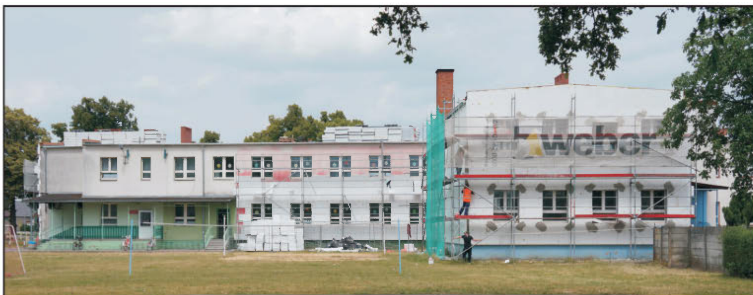
Prace termomodernizacyjne budynku Szkoły Podstawowej w Wilkowicach.
