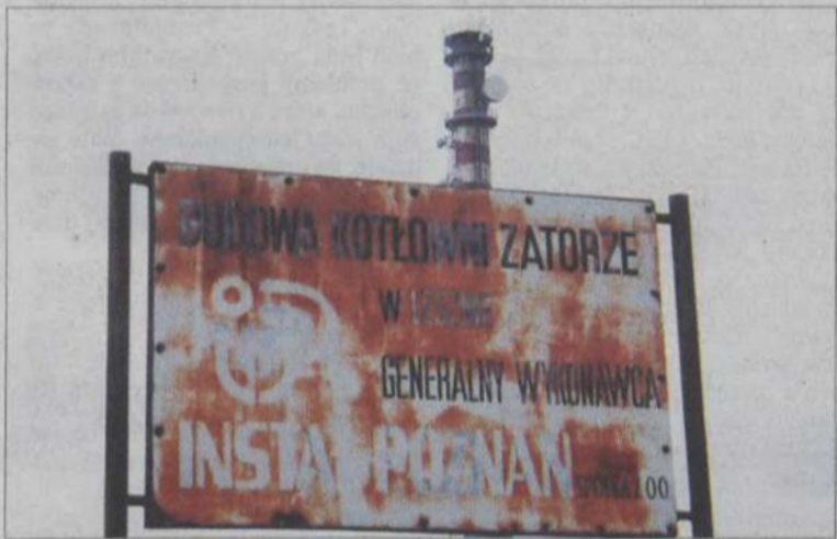
LESZNO. Nieco dziwnie prezentuje się nadgryziona rdzawym zębem czasu tablica informacyjna dotycząca budowy kotłowni — Zatorze zwłaszcza, że wspomniana kotłownia z powodzeniem działa już od trzech lat. (KB)
