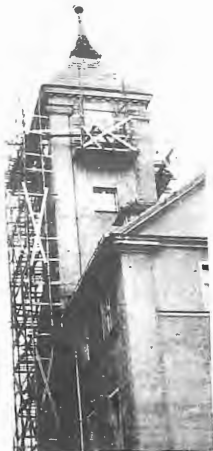
Wieża ratuszowa w Kościanie w czasie remontu w latach 1992, 1993
