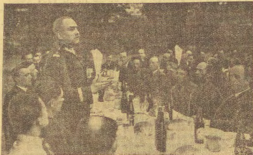
P. Premier podczas przemówienia na obiedzie wydanym dla robotników po ukończeniu prac na terenie Min. Spr. Wewn. w Warszawie.
