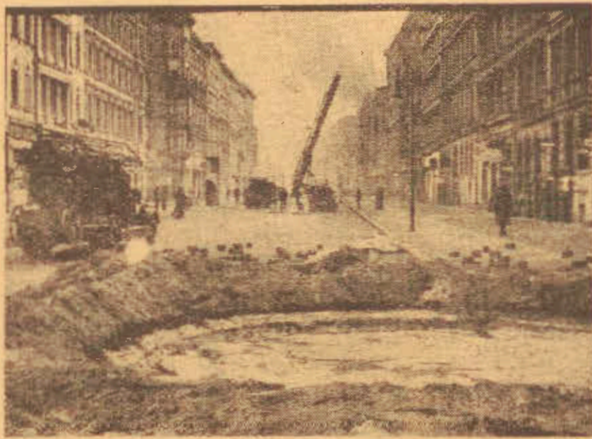
Ostatnio odbywały się nad Berlinem manewry niemieckiej floty powietrznej. Na zdjęciu na pierwszym planie widzimy wielką wyrwę po wybuchu granatu, a dalej oddział straży pożarnej przy akcji ratowniczej.
