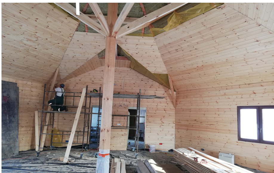
Prace wykończeniowe wewnątrz świetlicy w Dąbrowie
