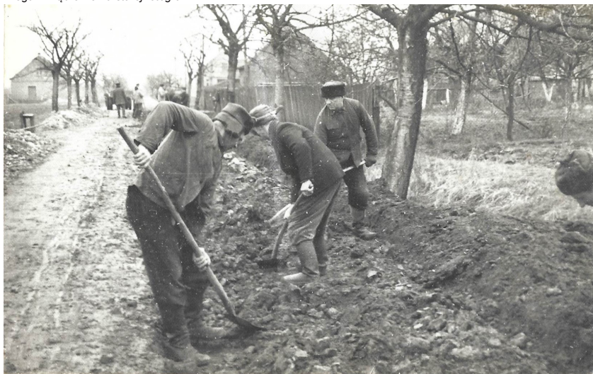
Prace przy utwardzeniu nawierzchni
