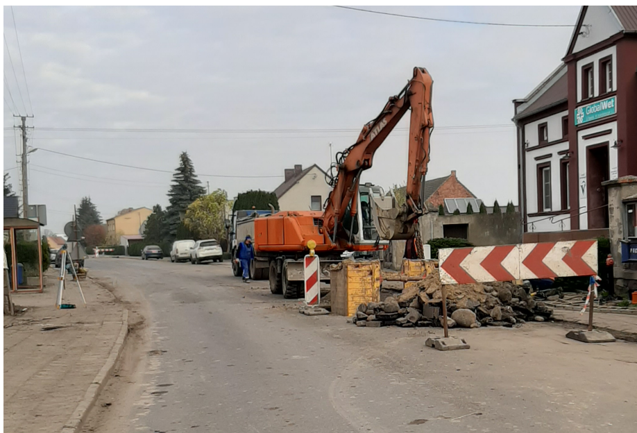
Budowa kanalizacji sanitarnej w Gostkowie
