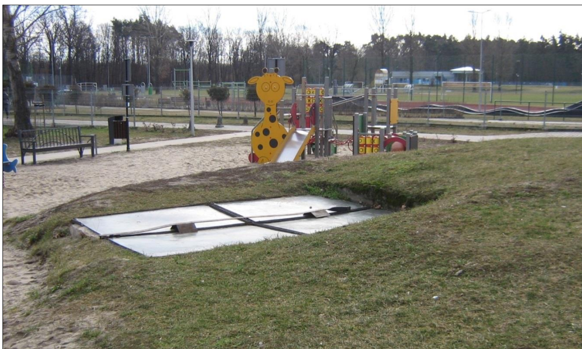
Zabezpieczone wejście do bunkra, 2022 r.
