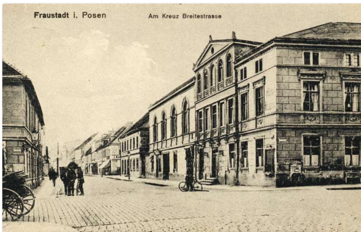
14. Budynek hotelu na rogu ulicy Breitestrasse (obecnie Niepodległości), ok. 1918 r. MZW, nr inw. MZW/837/AH. (Reprod. M. Kapała)
