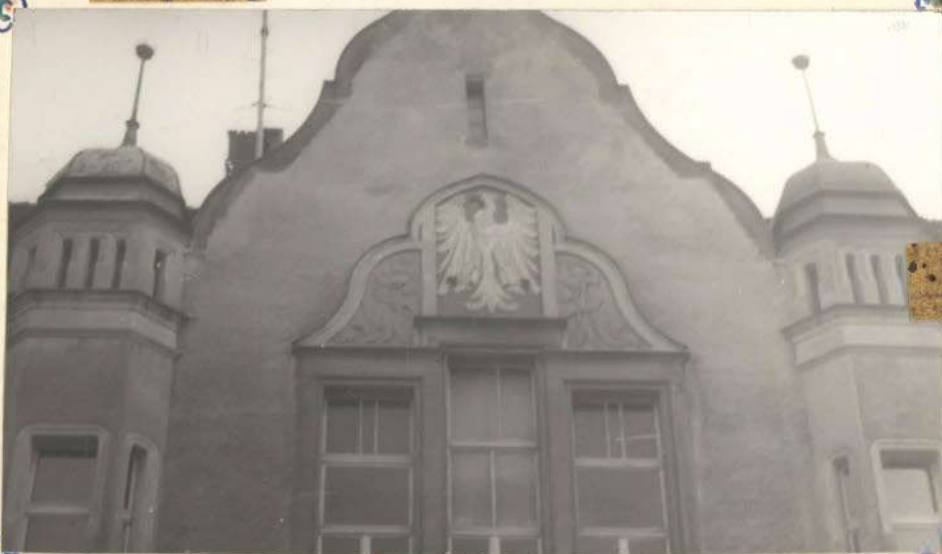
PIASTOWSKI ORZEŁ NA „STARYM” BUDYNKU UMIASTO GÓRZE
